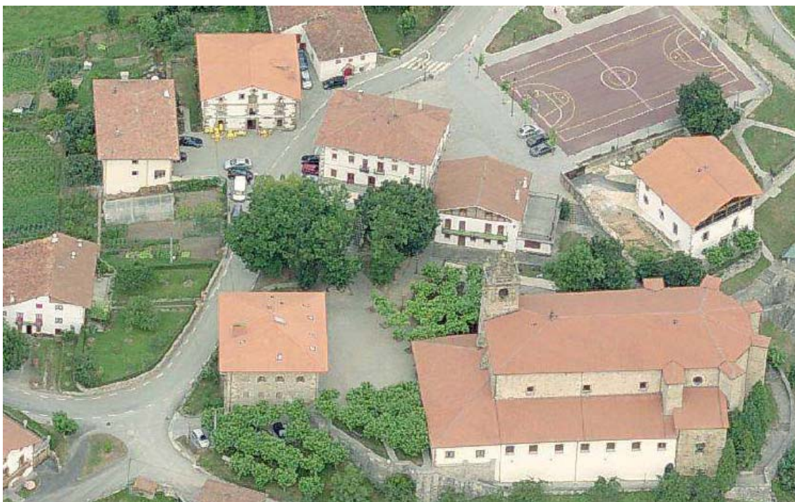
Vista general del casco de Gabiria
